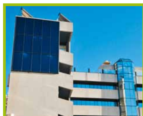
les panneaux solaires de l'École St Charles
